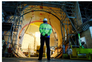
Construction de l'EPR à Flamanville. © Charly Triballeau/ AFP
